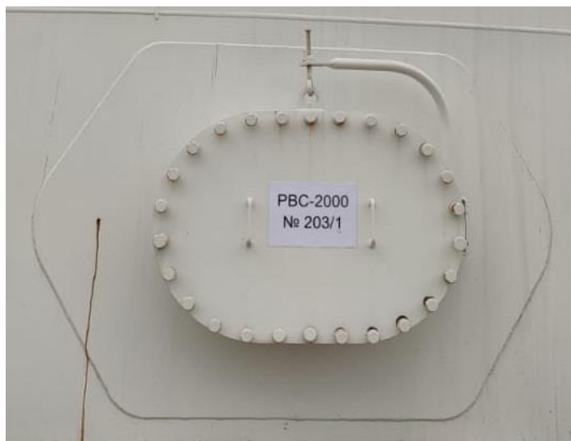
Рисунок 2 – Общий вид резервуаров РВС-2000
