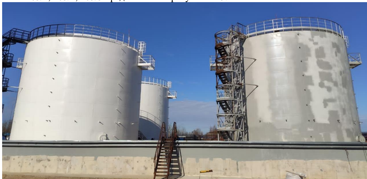
Рисунок 1 – Общий вид резервуаров РВС-2000
