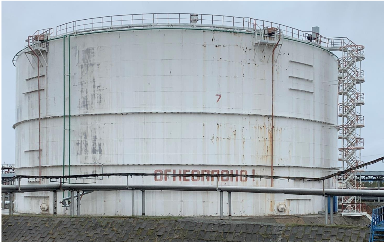
Рисунок 6 – Общий вид резервуаров РВС-20000
