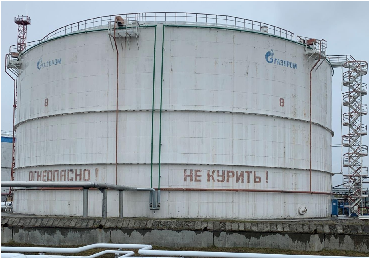
Рисунок 8 – Общий вид резервуаров РВС-20000
