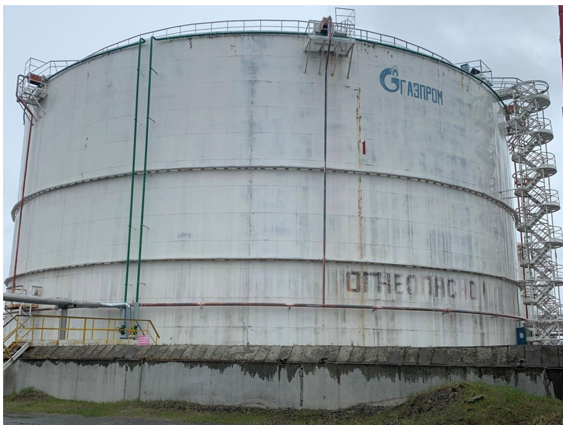
Рисунок 1 – Общий вид резервуаров РВС-20000
