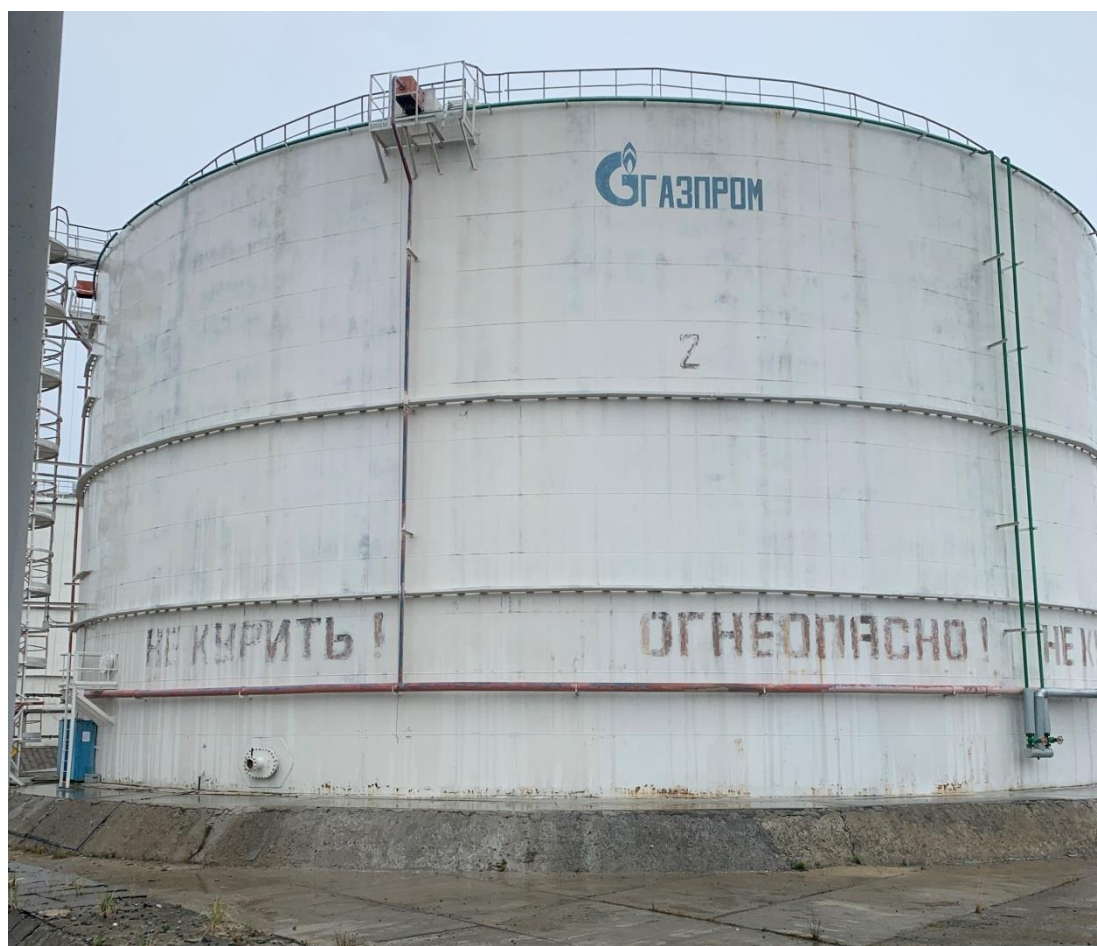
Рисунок 1 – Общий вид резервуаров РВС-20000
