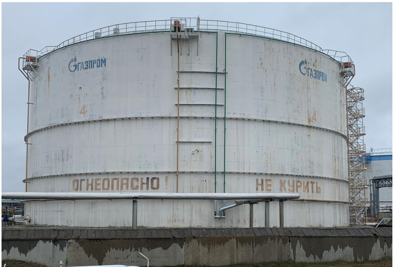
Рисунок 4 – Общий вид резервуаров РВС-20000
