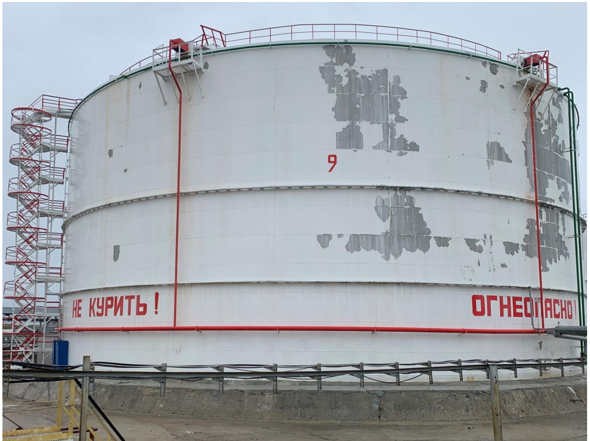
Рисунок 9 – Общий вид резервуаров РВС-20000
