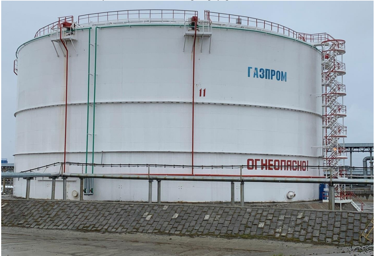
Рисунок 11 – Общий вид резервуаров РВС-20000
