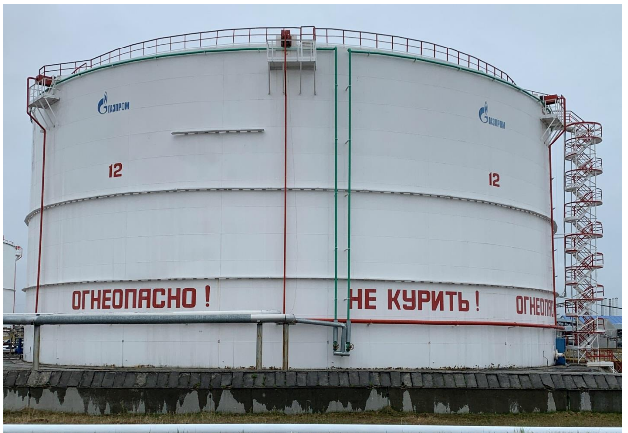
Рисунок 11 – Общий вид резервуаров РВС-20000
