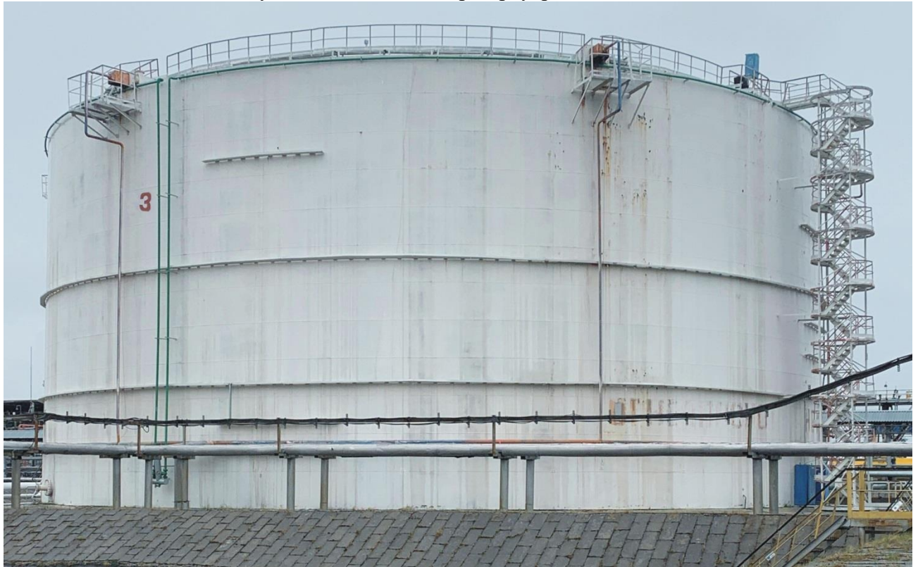
Рисунок 3 – Общий вид резервуаров РВС-20000
