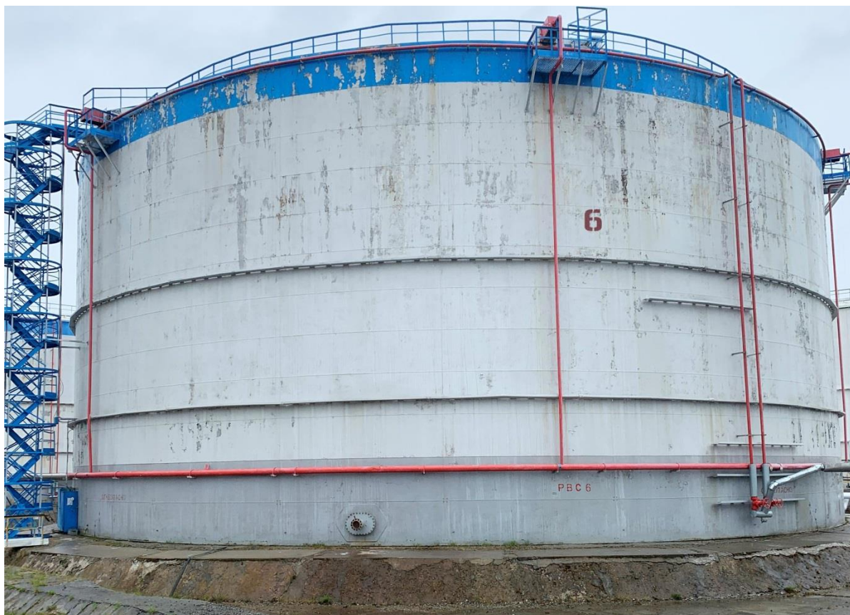
Рисунок 5 – Общий вид резервуаров РВС-20000
