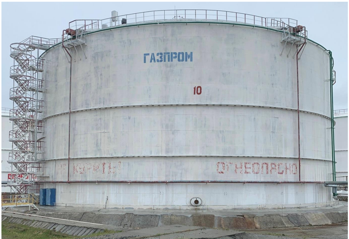
Рисунок 9 – Общий вид резервуаров РВС-20000
