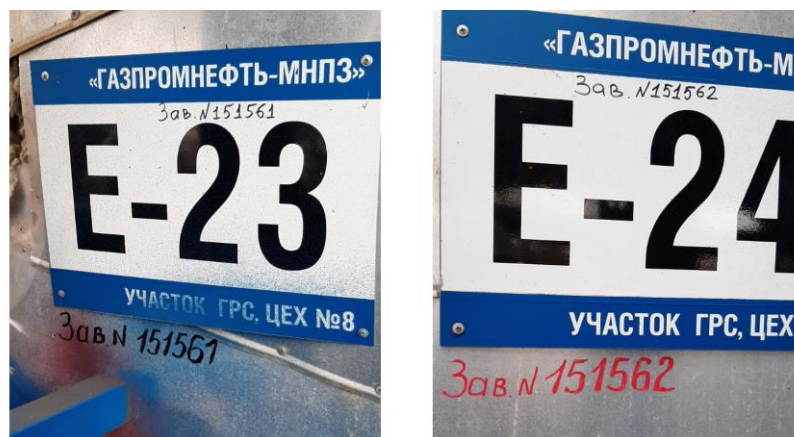
Рисунок 1 – Место нанесения заводских номеров
