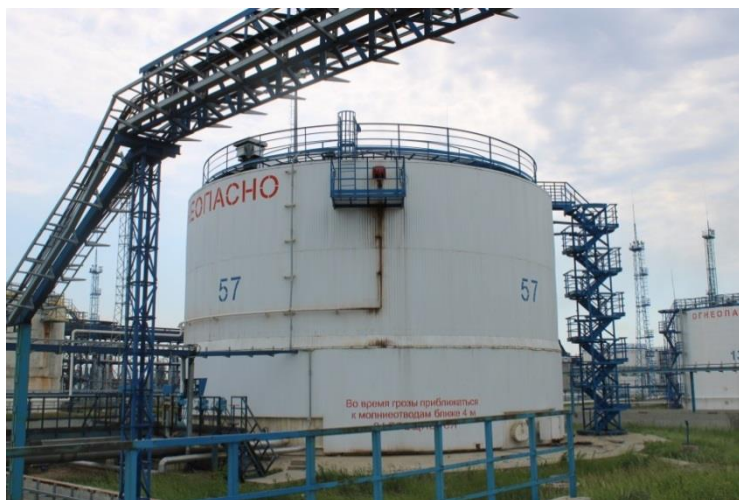
Рисунок 1 – Общий вид резервуара стального вертикального цилиндрического РВС-3000
