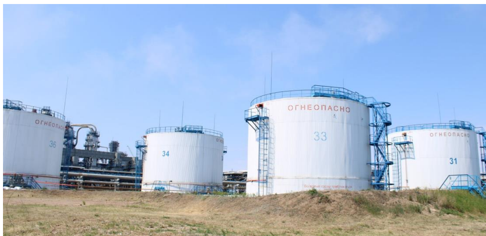
Рисунок 1 – Общий вид резервуаров стальных вертикальных цилиндрических РВС-2000
