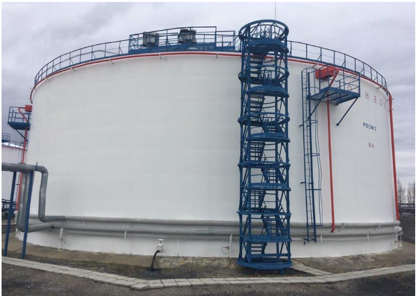
Рисунок 1 - Общий вид РВС-10000
