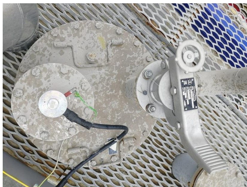
Рисунок 2 – Общий вид резервуара РГС-20
