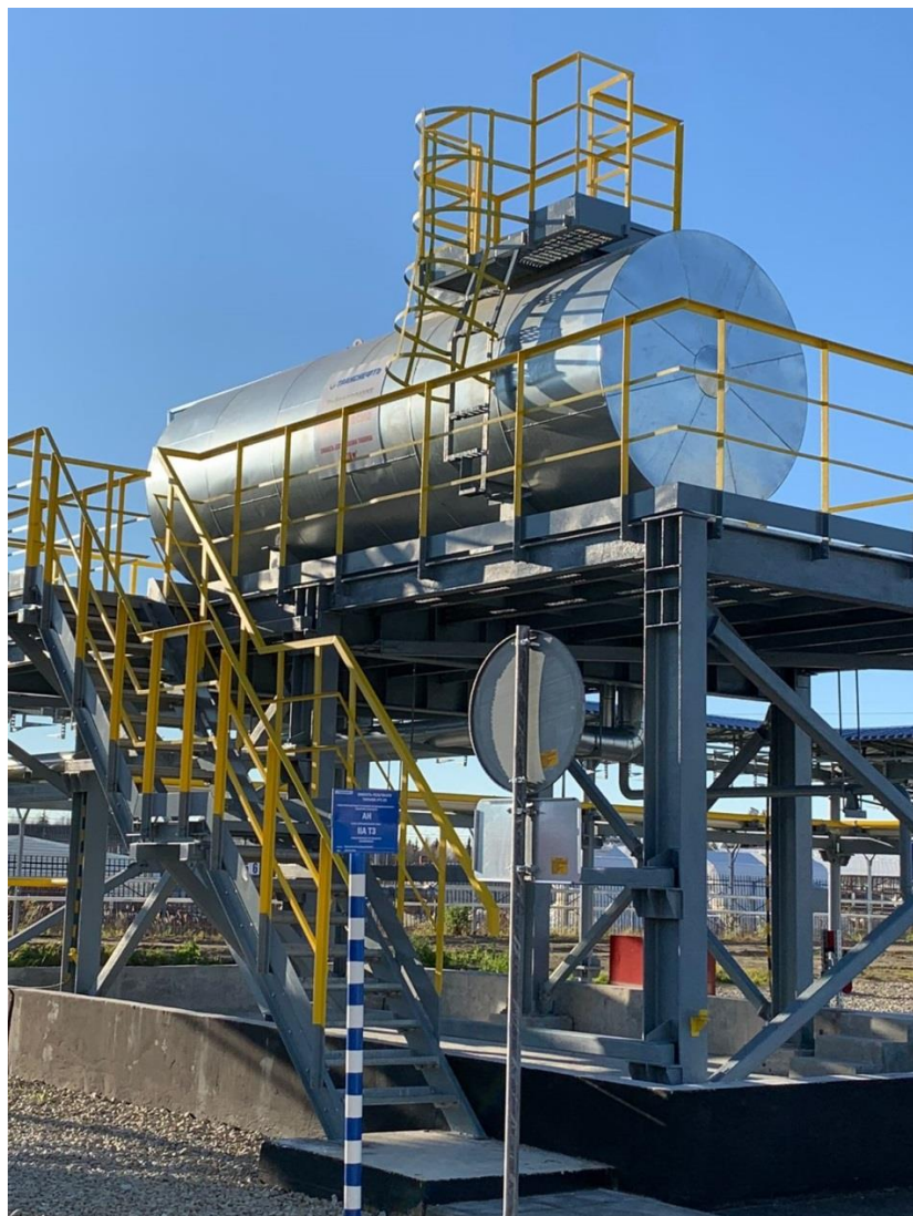
Рисунок 1 – Общий вид резервуара РГС-20
