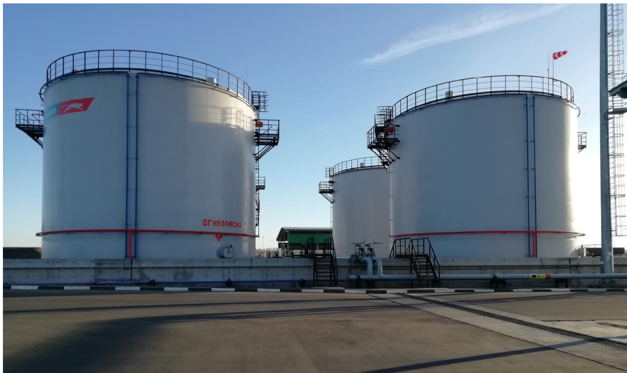
Рисунок 1 - Общий вид резервуаров РВС-1950
