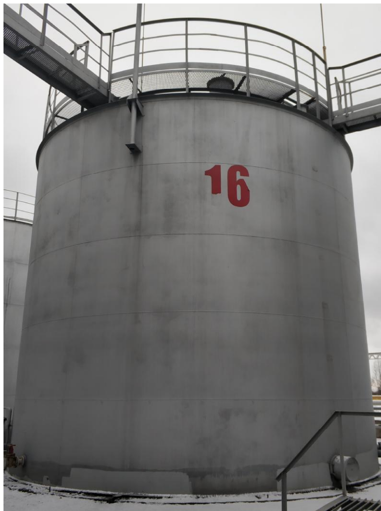
Рисунок 1 - Общий вид резервуара РВС-400
