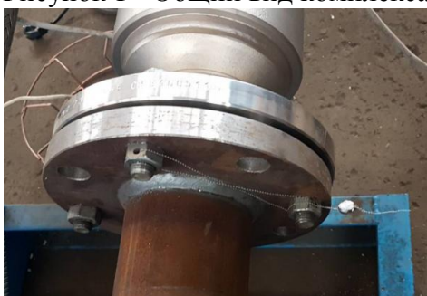
Рисунок 3 - Пломба поверителя, препятствующая демонтажу CRM
