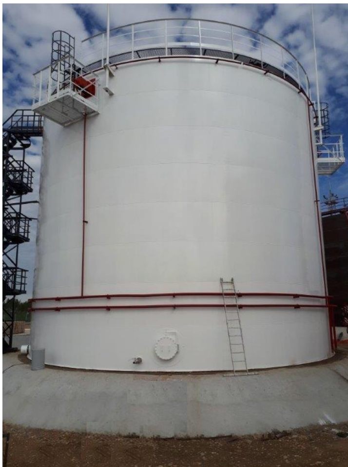
Рисунок 1 - Общий вид резервуара РВС-2000
