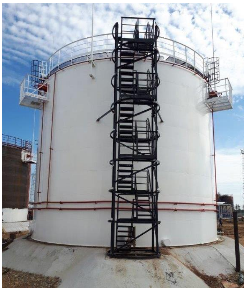
Рисунок 1 - Общий вид резервуара РВСП-2000
