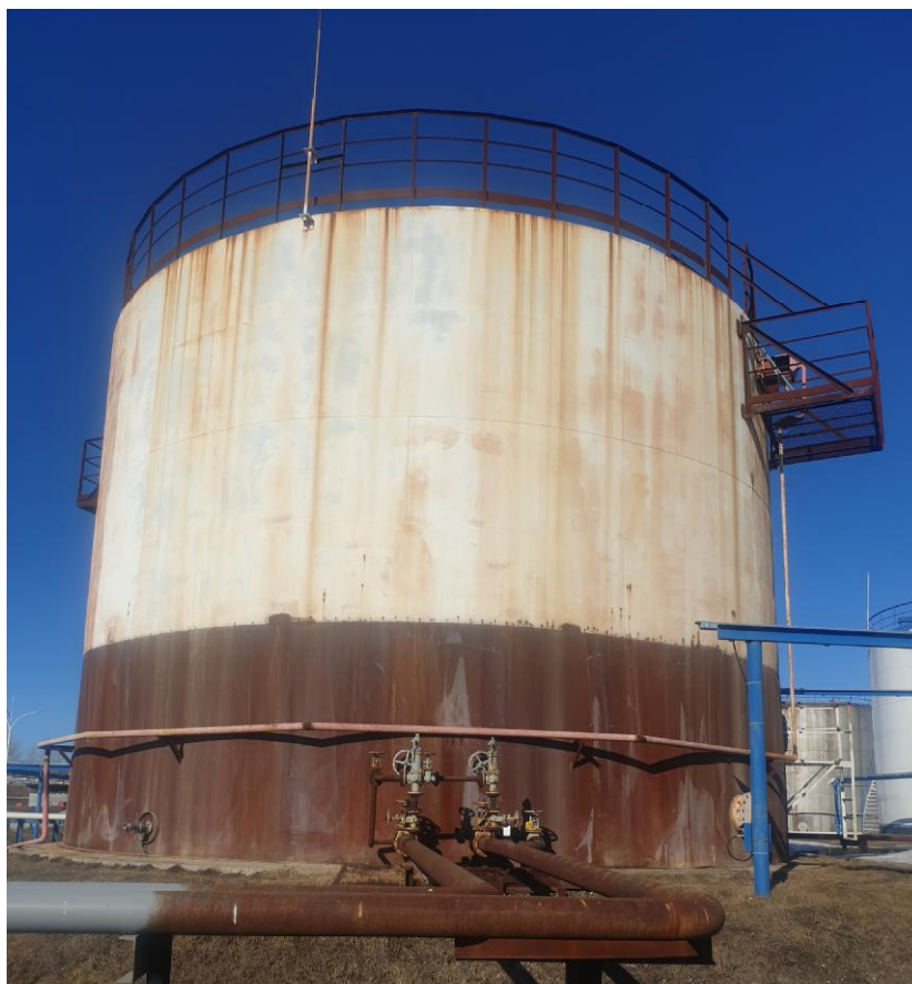
Рисунок 1 - Общий вид резервуара вертикального стального цилиндрического РВСП-1000
