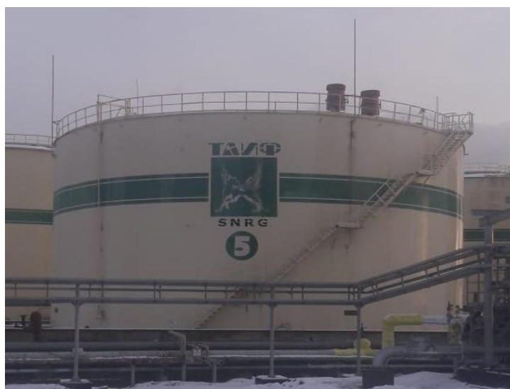
Рисунок 3 - Общий вид резервуаров вертикальных стальных цилиндрических РВС-5000
