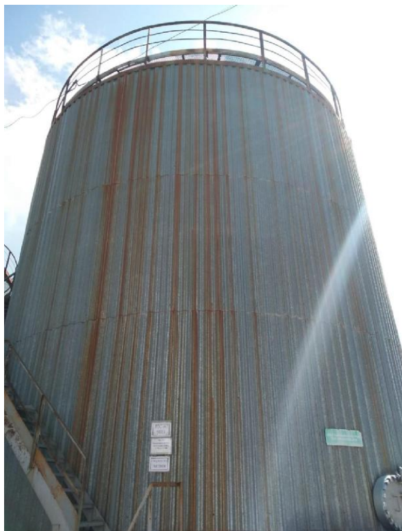
Рисунок 1 - Общий вид резервуаров вертикальных стальных цилиндрических РВС-750
