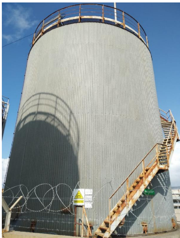
Рисунок 2 - Общий вид резервуаров вертикальных стальных цилиндрических РВС-1000
