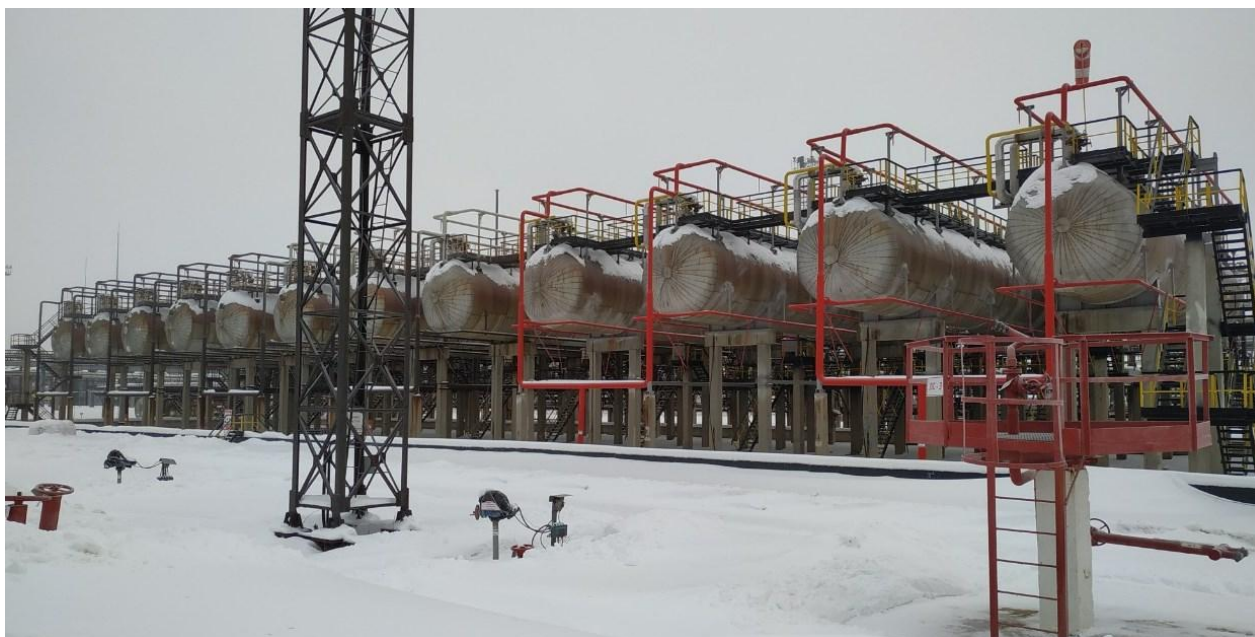
Рисунок 1 - Общий вид резервуара стального горизонтального цилиндрического РГС-200
