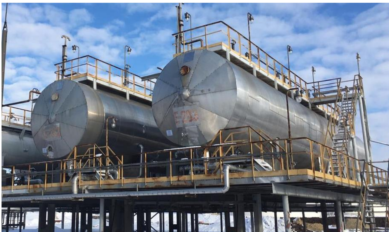
Рисунок 1 - Общий вид резервуара стального горизонтального цилиндрического РГС-200(70+70+60), РГС-200(60+80+60)
