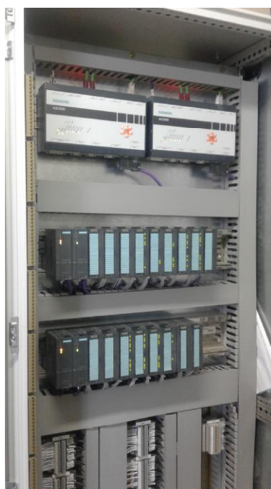
Рисунок 2 - Общий вид шкафа контроллеров
