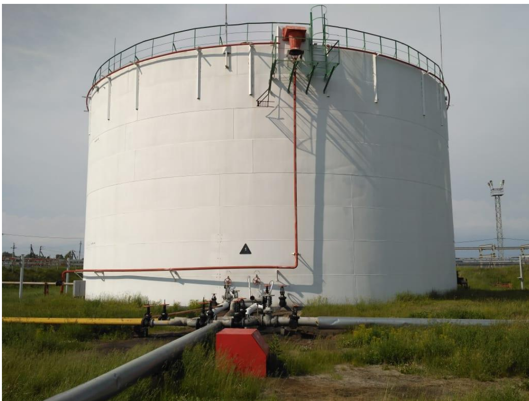
Рисунок 1 - Общий вид резервуара вертикального стального цилиндрического РВС-5000 зав. № 1
