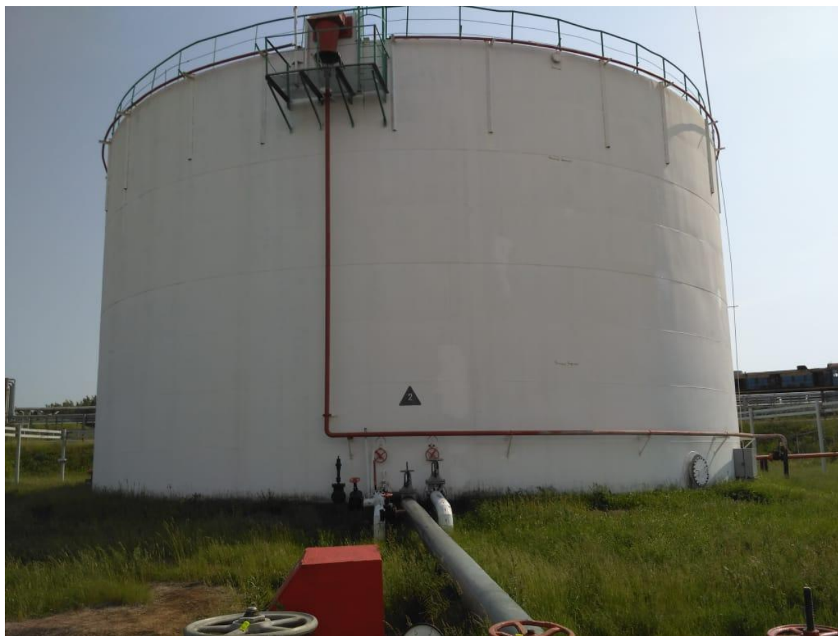
Рисунок 2 - Общий вид резервуара вертикального стального цилиндрического PVC-5000 зав. № 2
