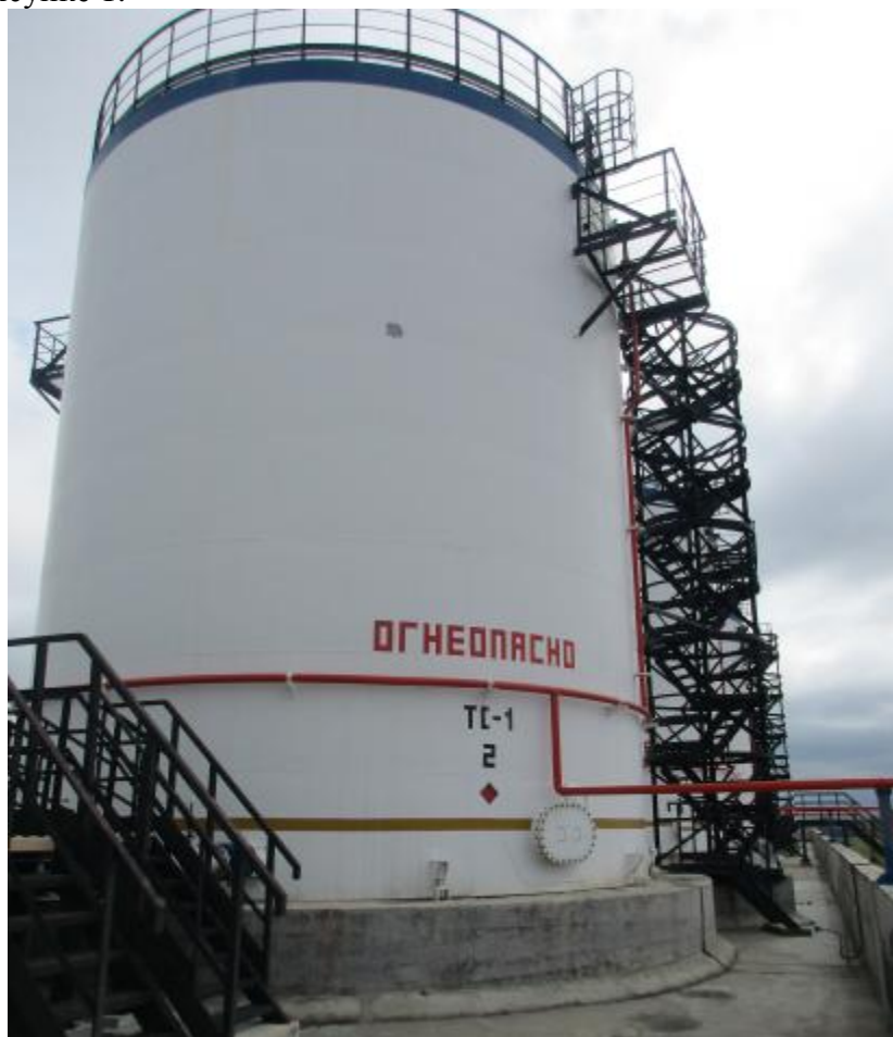
Рисунок 1 – Общий вид резервуара РВС-1000
