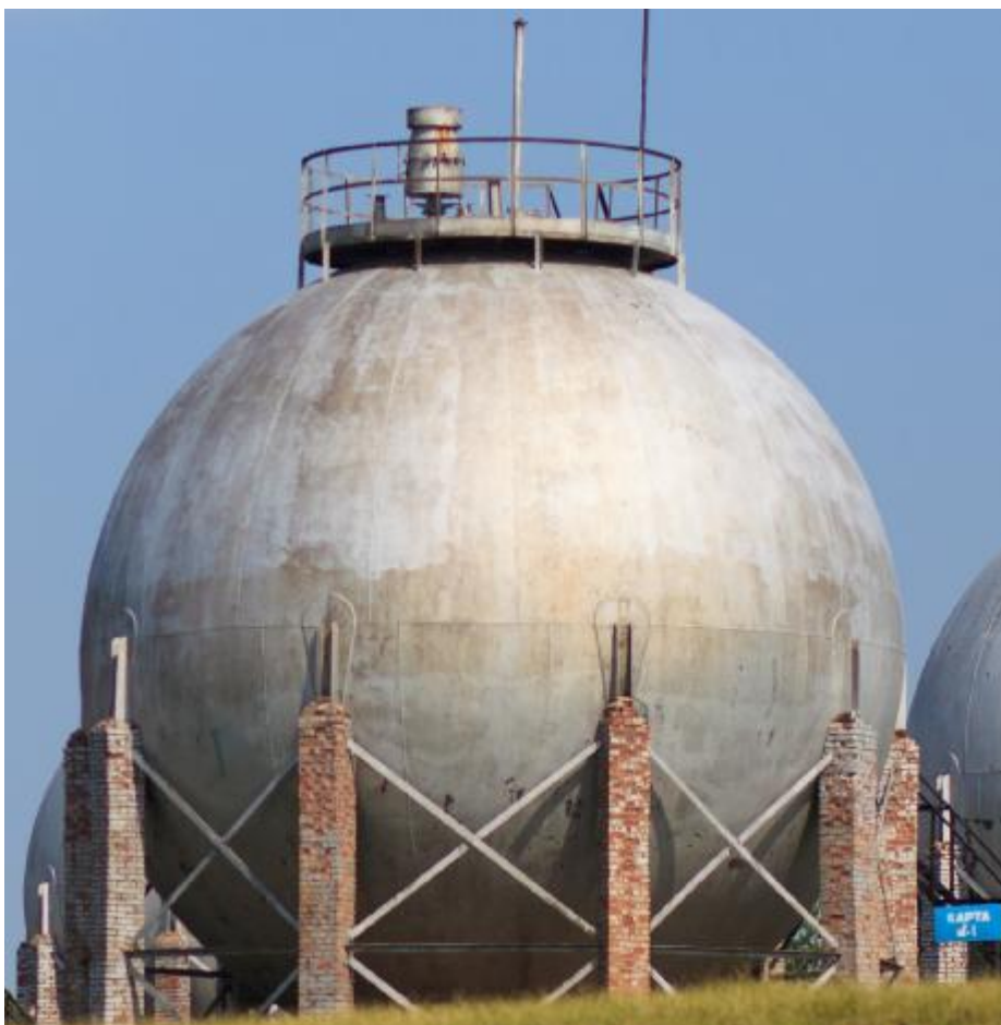
Рисунок 1 - Общий вид резервуара РШС-600
