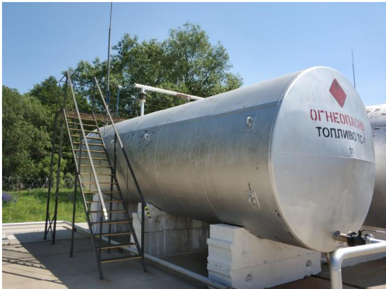
Рисунок 1 – Общий вид резервуара РГС-50
