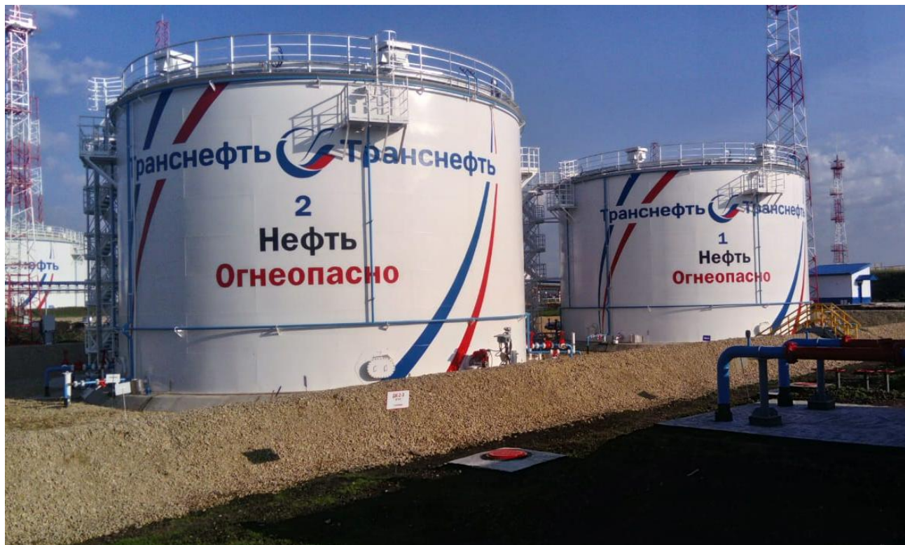
Рисунок 1 – Общий вид резервуаров РВС-3000
