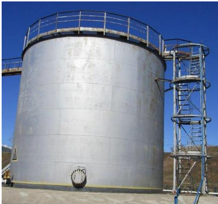
Рисунок 1 – Общий вид резервуара вертикального стального цилиндрического РВС-700.
