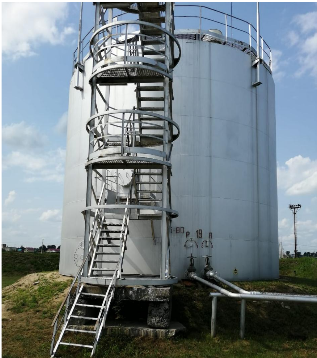
Рисунок 1 – Общий вид резервуара стального вертикального цилиндрического РВСП-700
