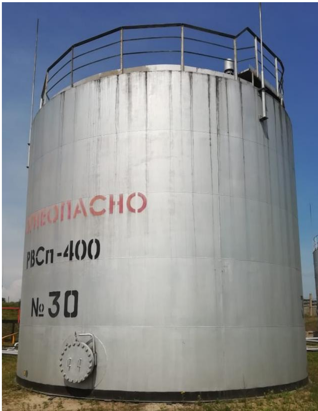
Рисунок 1 – Общий вид резервуара стального вертикального цилиндрического РВСП-400
