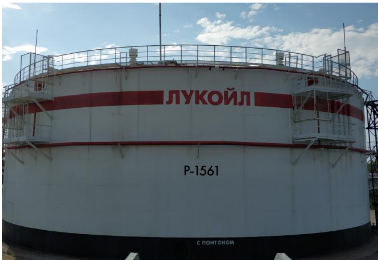
Рисунок 1 – Общий вид резервуара РВСП-10000
