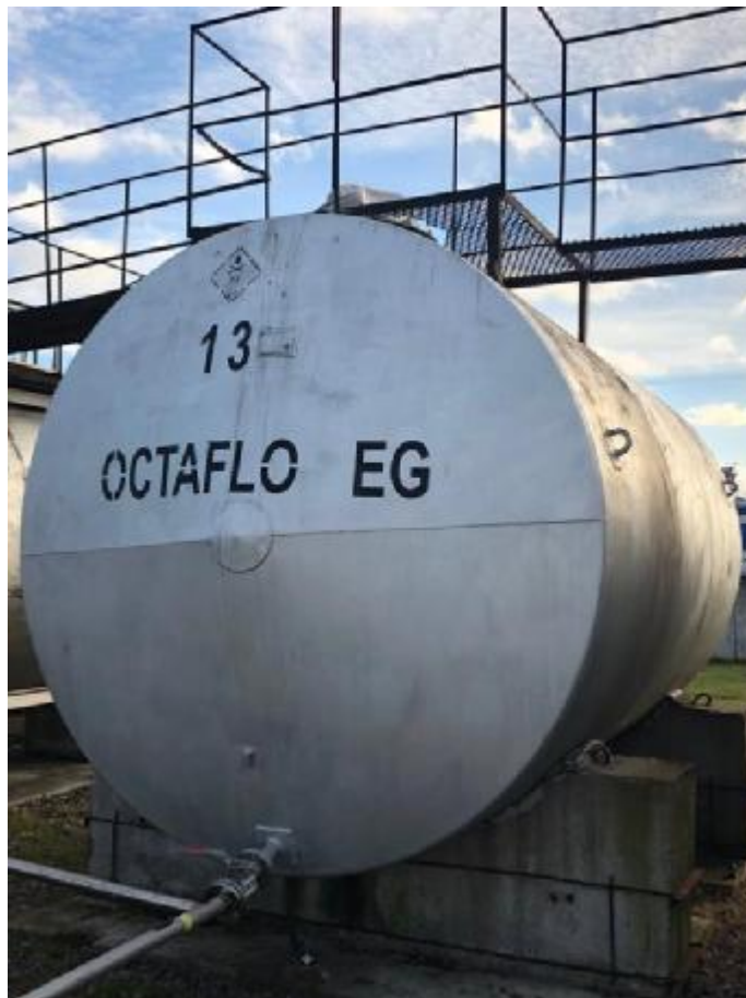
Рисунок 1 – Общий вид резервуаров РГС-25
