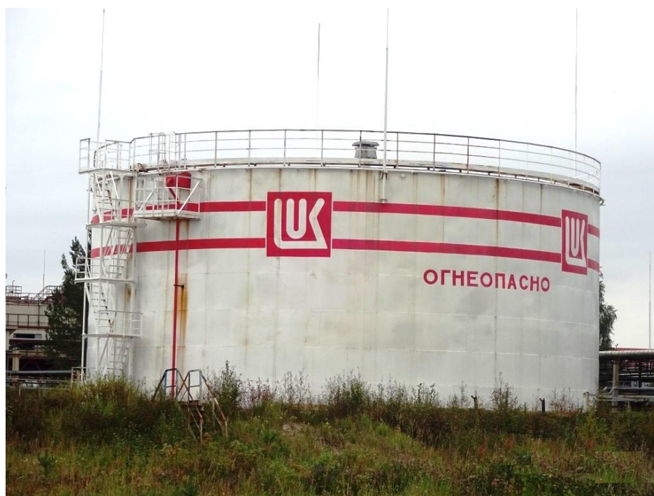
Рисунок 1 – Общий вид резервуаров РВС-5000 №№ 1, 2, ба
