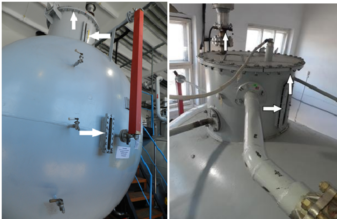
Рисунок 2 – Схема пломбировки мерника Г4-ВИЦ-1000 зав. № 8180 от несанкционированного доступа
