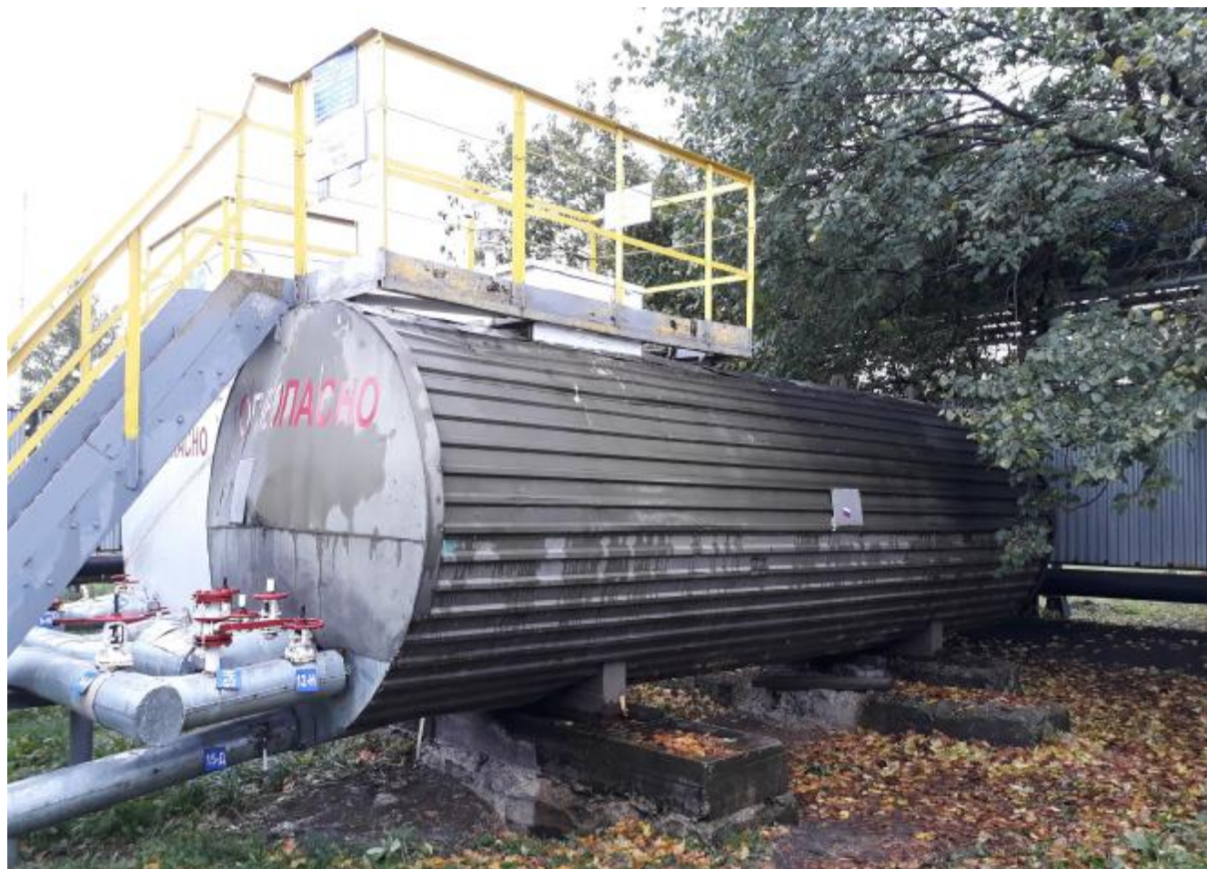
Рисунок 1 – Общий вид резервуара РГС-20
