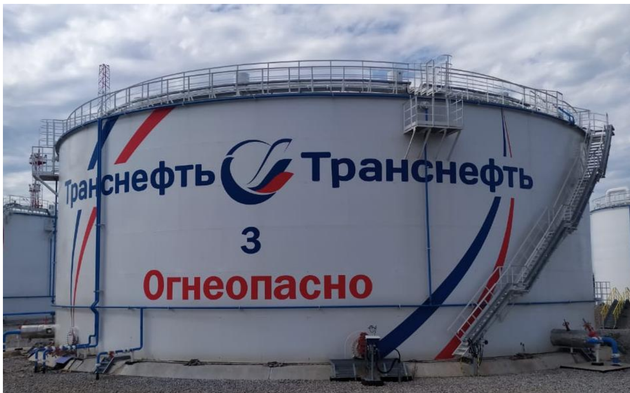
Рисунок 1 – Общий вид резервуара РВСП-10000
