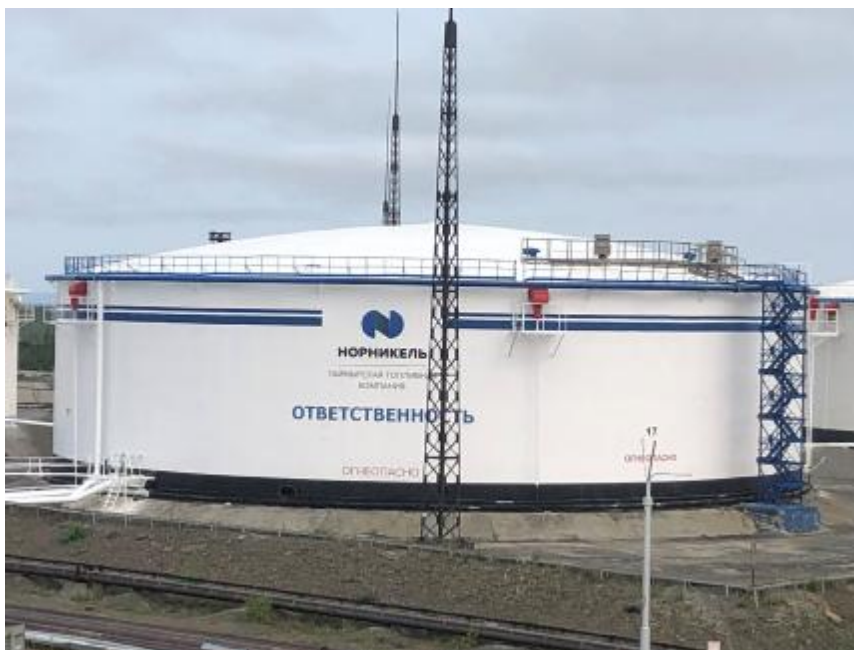
Рисунок 1 – Общий вид резервуаров РВС-1000, РВС-2000, РВС-5000, РВС-20000
