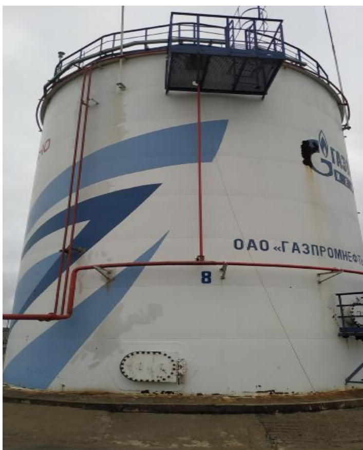
Рисунок 1 – Общий вид резервуара вертикального стального цилиндрического РВСП-1000
