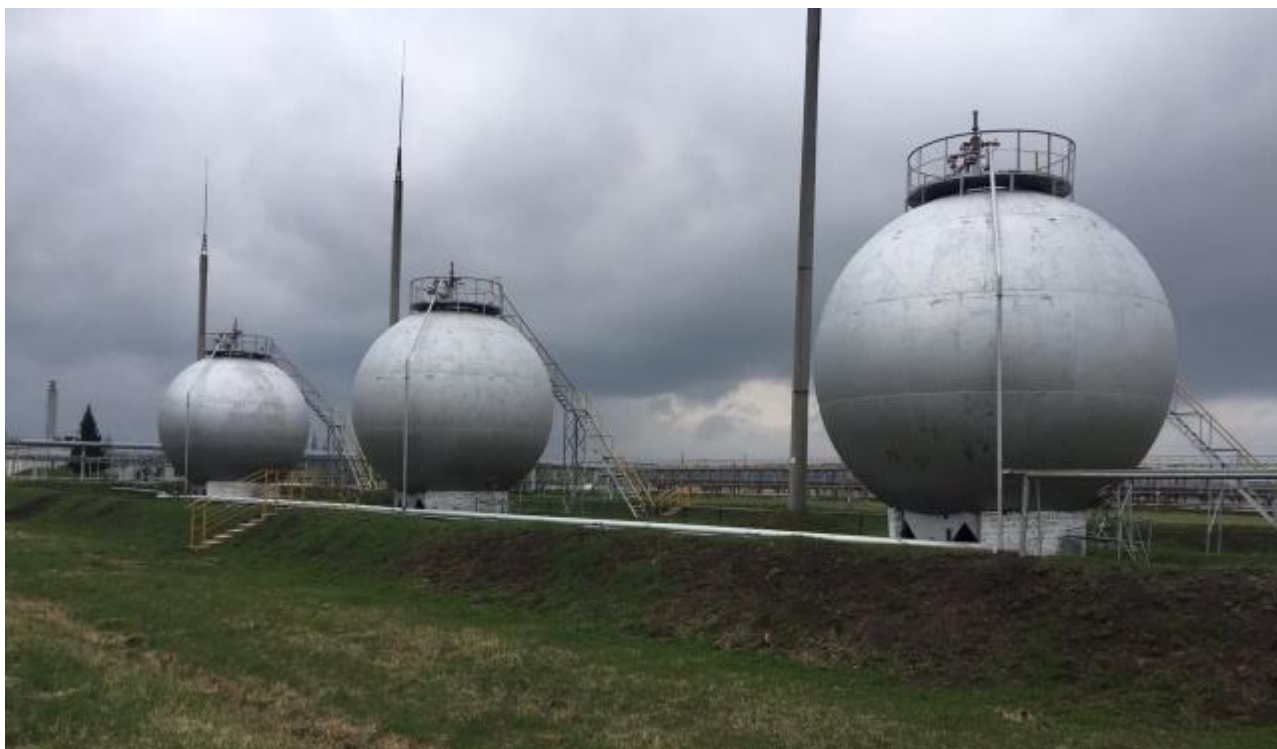
Рисунок 1 – Общий вид резервуаров РШС-600
