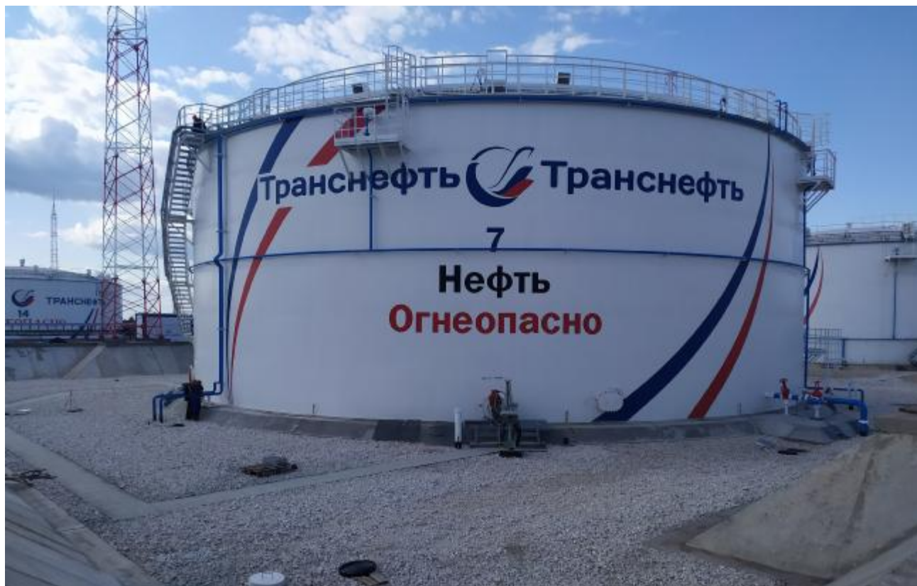
Рисунок 1 – Общий вид резервуара РВСП-10000
