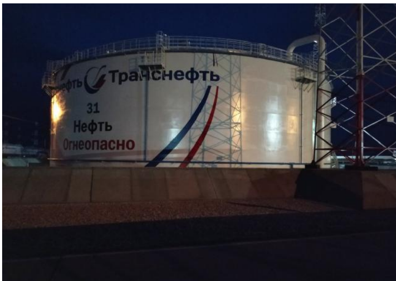
Рисунок 1 – Общий вид резервуара РВС-20000
