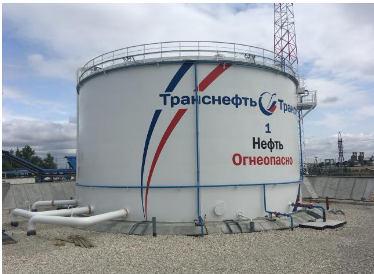
Рисунок 1 – Общий вид резервуара РВС-5000
