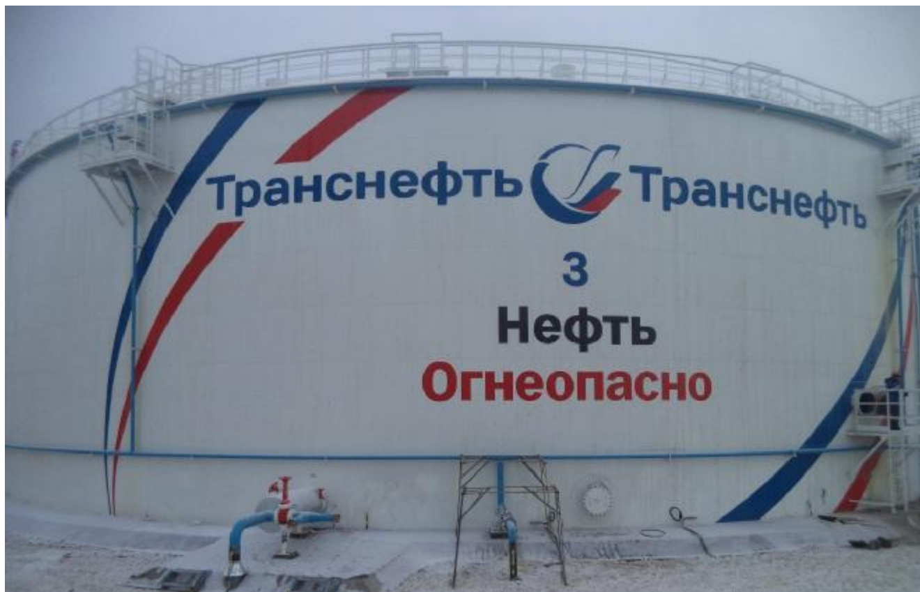
Рисунок 1 – Общий вид резервуара РВСП-20000
