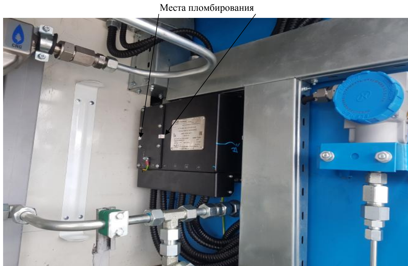
Рисунок 3 – Места пломбирования системы отпуска в целях предотвращения несанкционированной настройки и вмешательства
