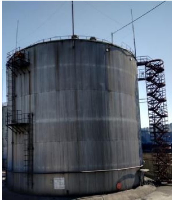
Рисунок 1 – Общий вид резервуара
