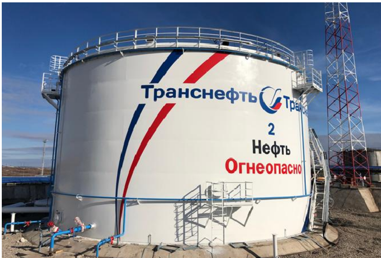
Рисунок 1 – Общий вид резервуара РВСП-5000
