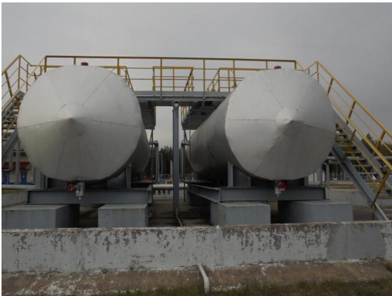
Рисунок 1 – Общий вид резервуаров РГС-40
