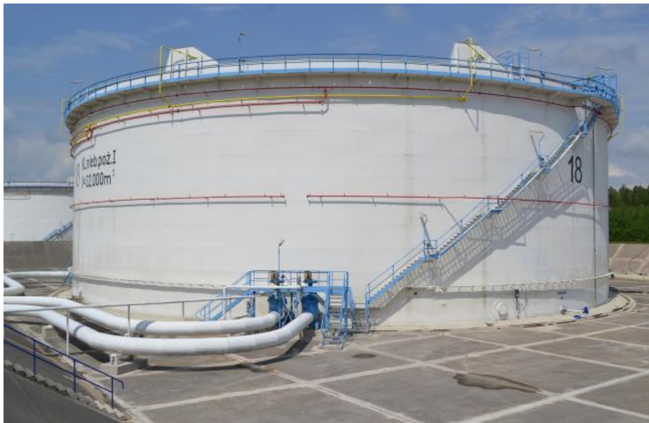
Рисунок 1 – Общий вид резервуара РВСПК-32000
