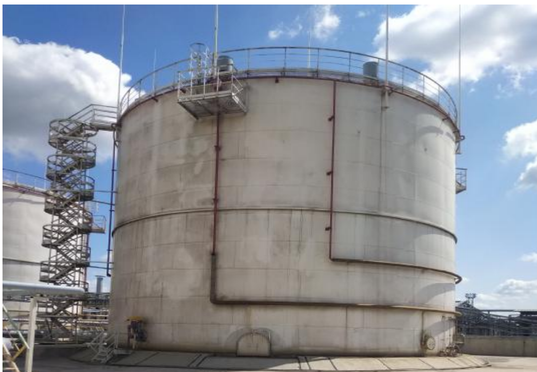
Рисунок 1 – Общий вид резервуара стального вертикального цилиндрического РВСп-5000
