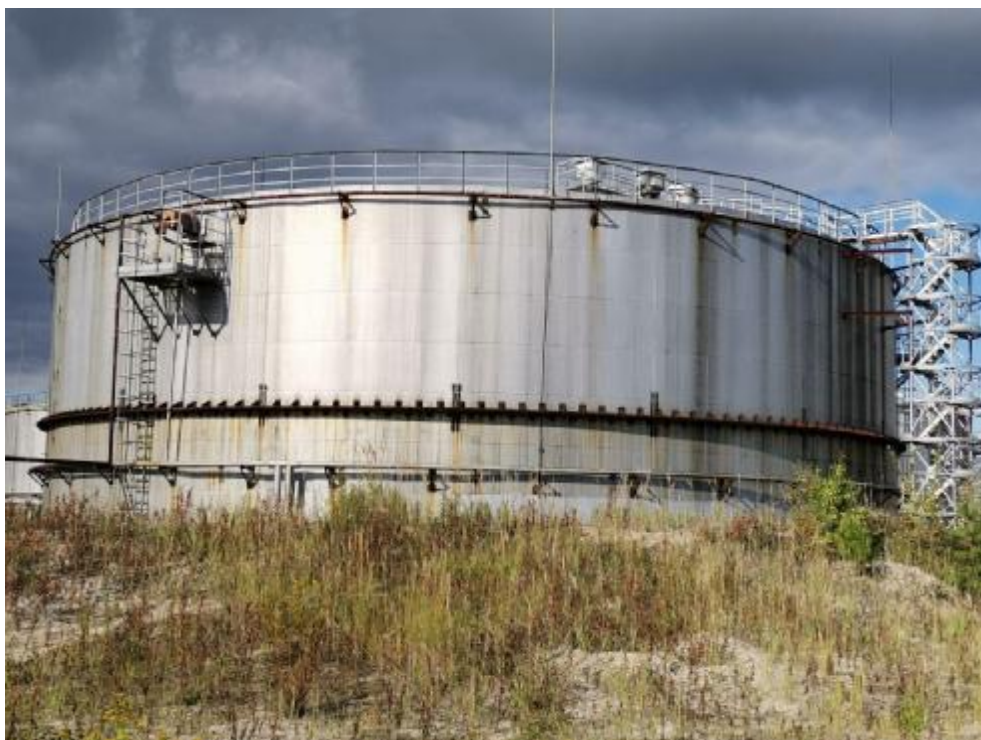
Рисунок 1 – Общий вид резервуаров стальных вертикальных цилиндрических РВС-10000 зав.№ 30, № 35, № 36
