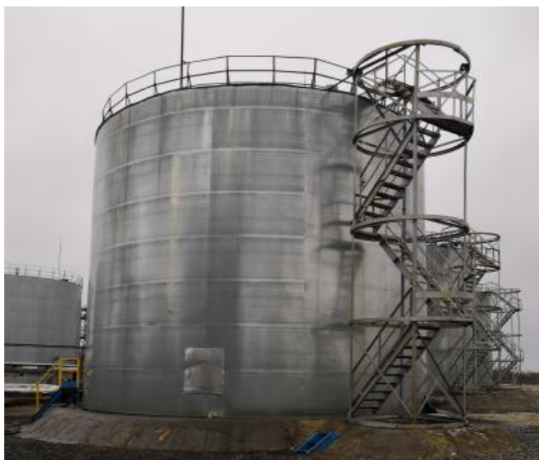
Рисунок 1 – Общий вид резервуара вертикального стального цилиндрического теплоизолированного РВС-700
