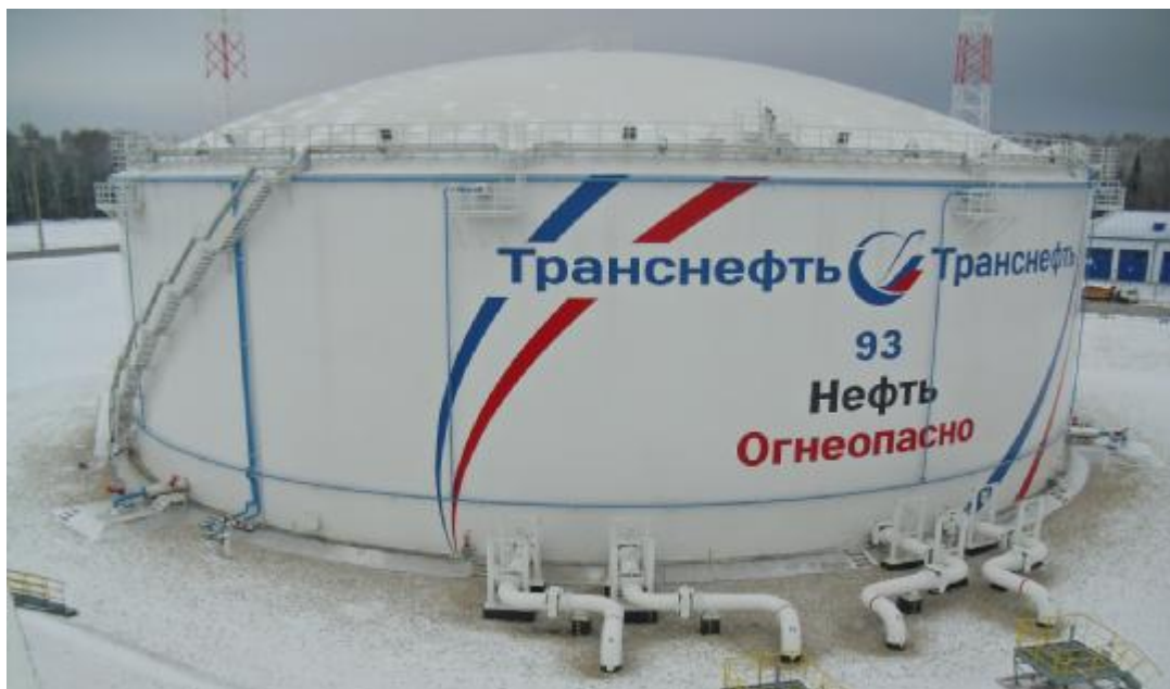
Рисунок 2 – Общий вид резервуара РВСП-50000 зав.№ 93
