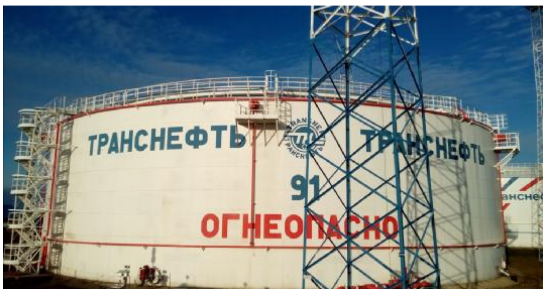
Рисунок 1 – Общий вид резервуара РВС-20000 зав.№ 91
