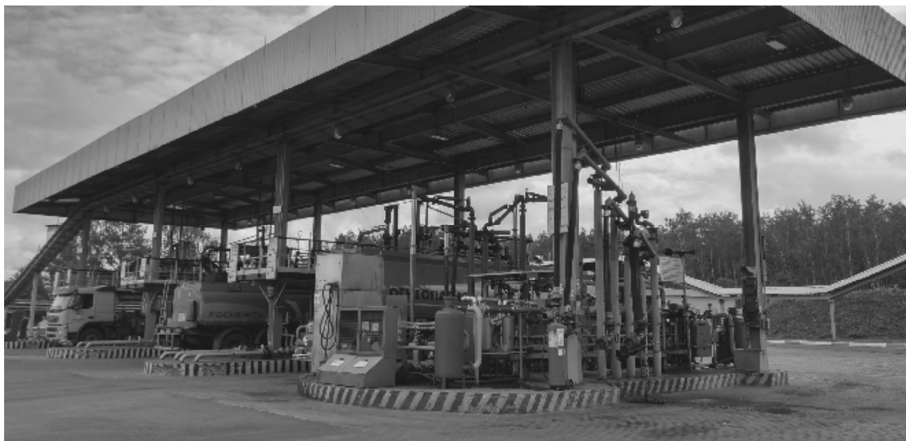
Рисунок 1 - Общий вид комплекса измерения массы нефтепродуктов АСН КИМ-Брянск
