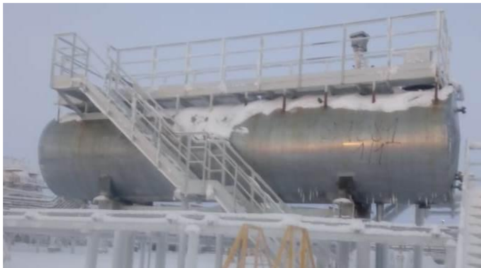
Рисунок 1 – Общий вид резервуара стального горизонтального цилиндрического РГС-50
