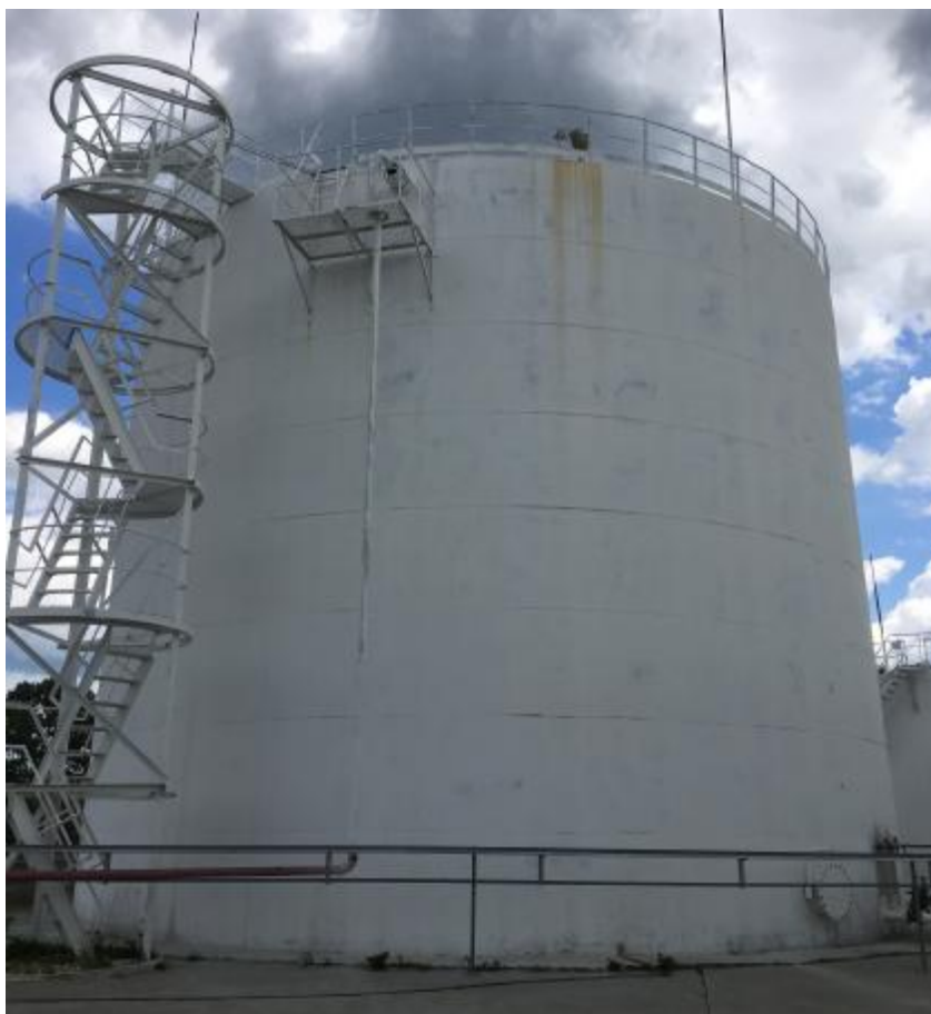
Рисунок 2 – Общий вид резервуаров стальных вертикальных цилиндрических РВС-2000
